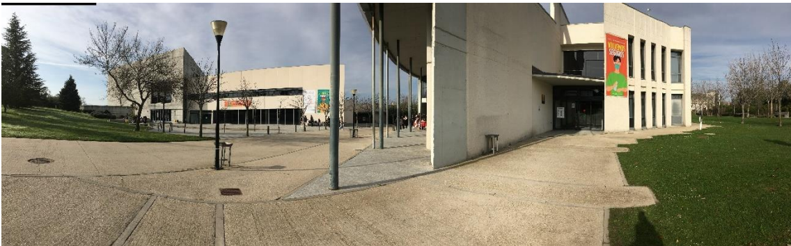
Figura 19: Interior del campus de Colmenarejo.
