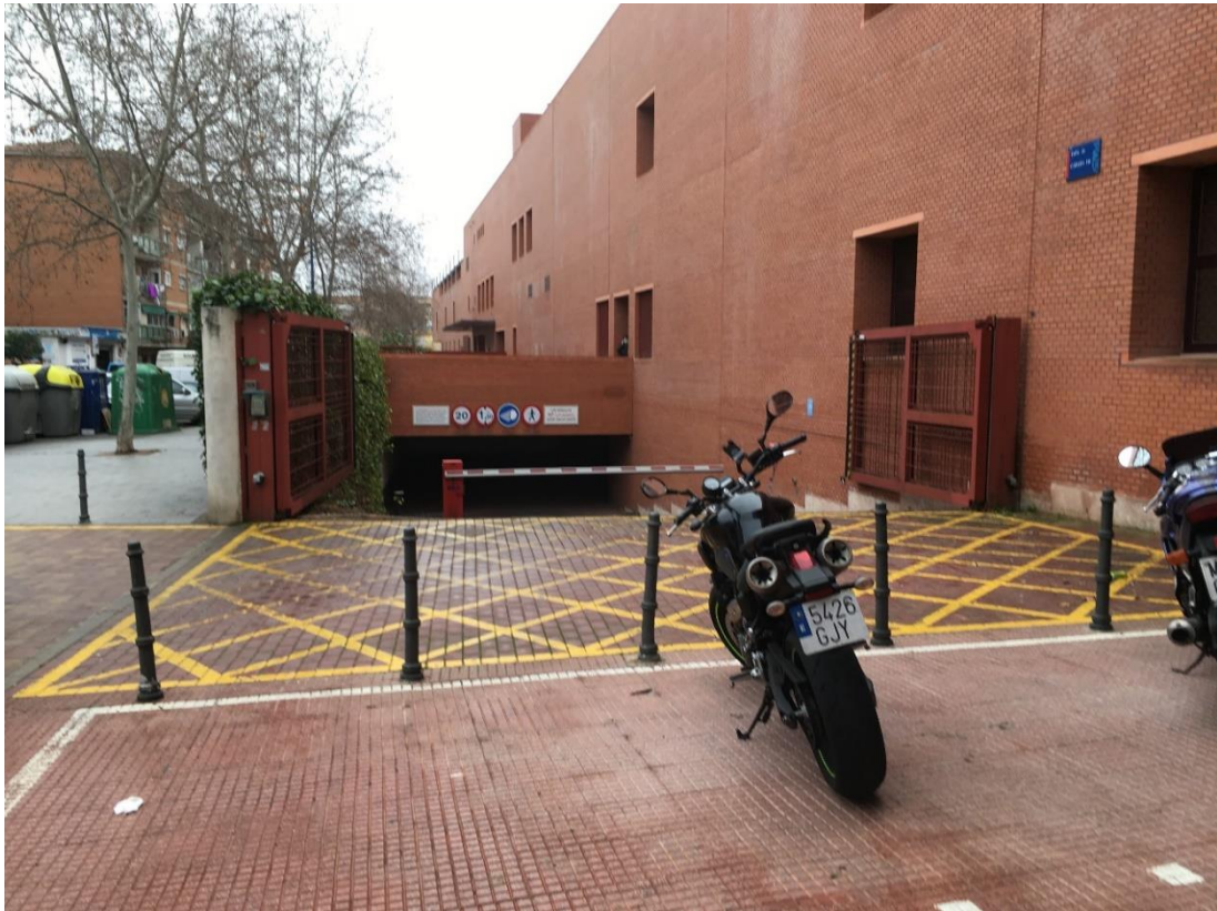
Figura 7: Aparcamiento con control de acceso en Leganés (UC3M).
