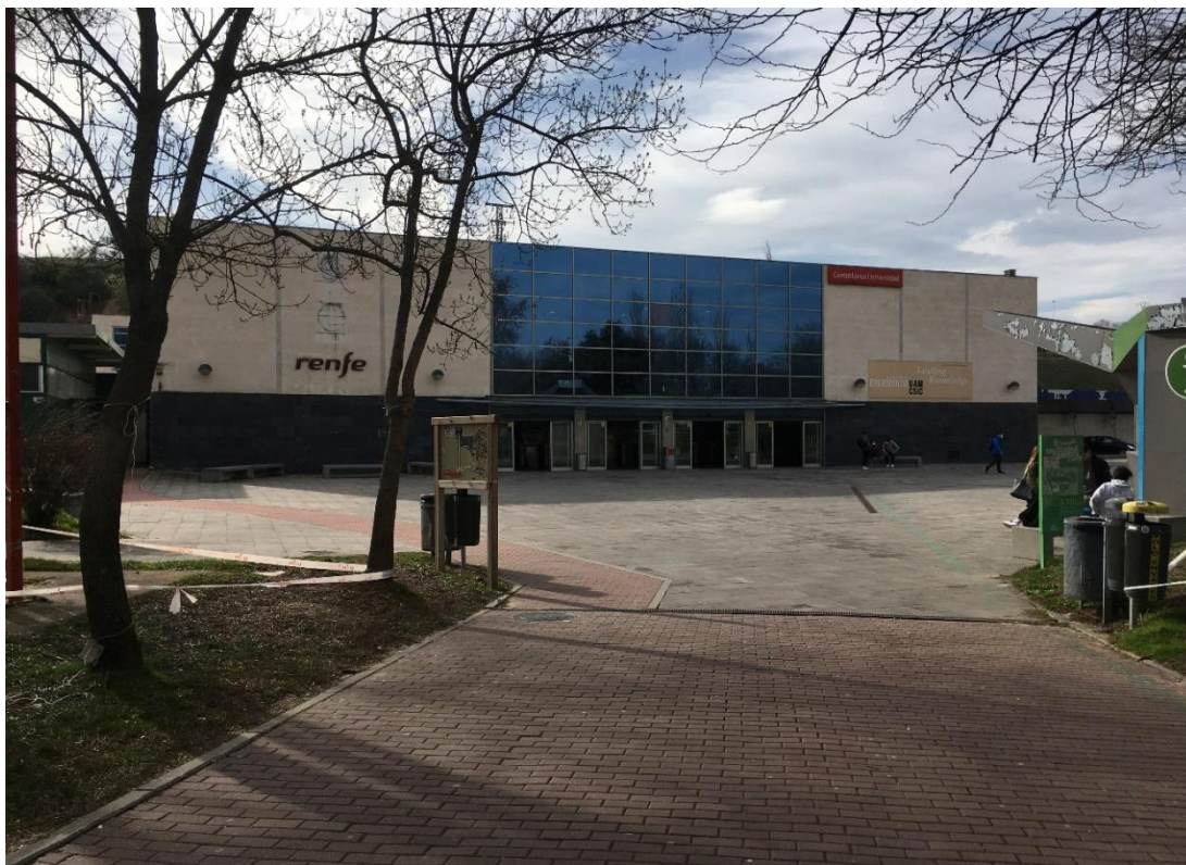
Figura 5: Estación de Cercanías en Cantoblanco (UAM).
