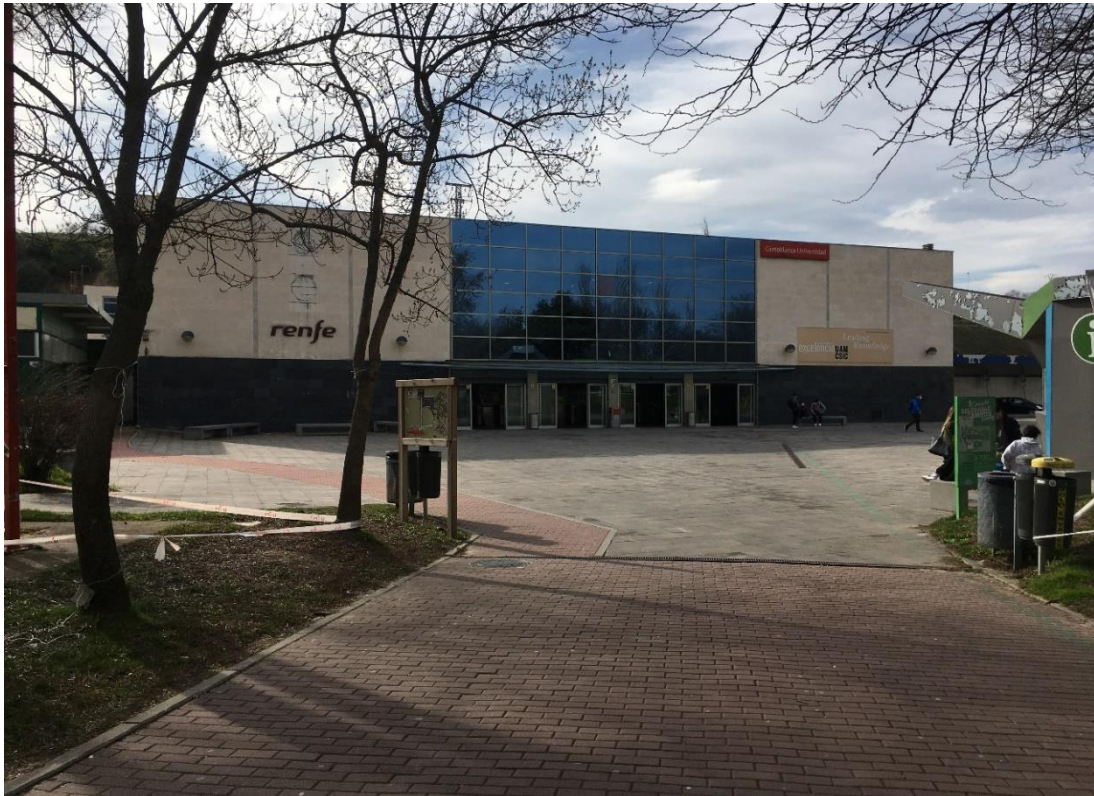
Figura 5: Estación de Cercanías en Cantoblanco (UAM).
